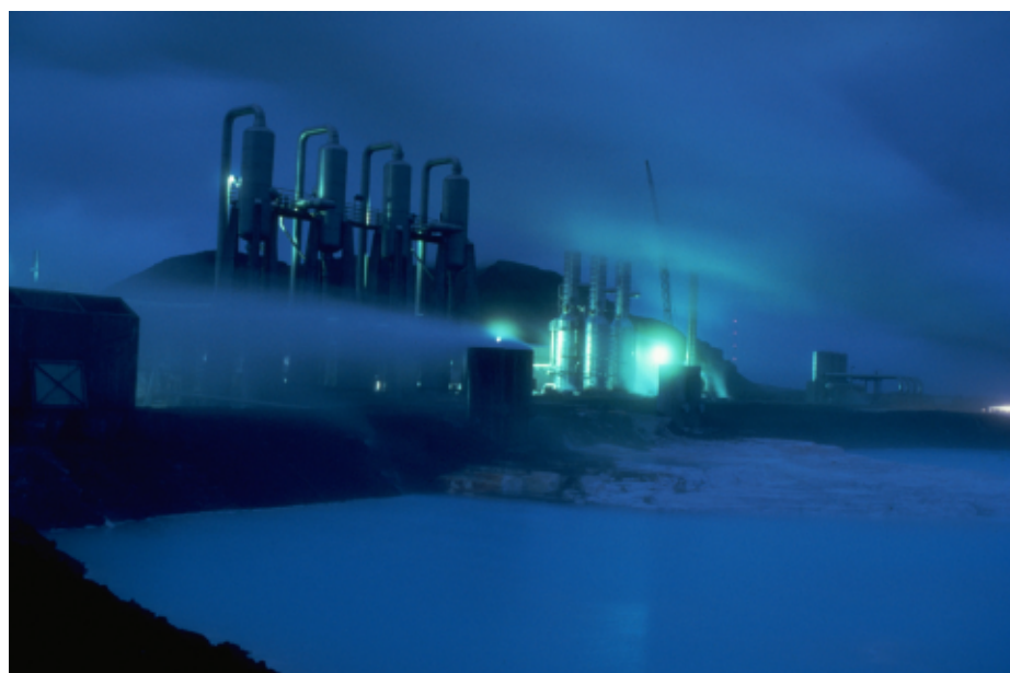
Геотермальная станция, Исландия
